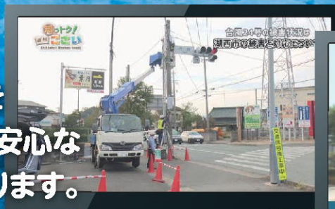
復旧作業中継
